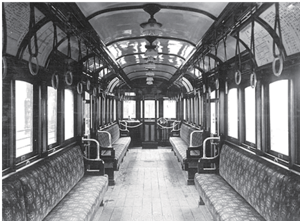
竣工当時の室内。モケットには京都市電気局の局紋があしらわれている。
