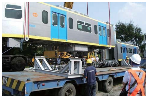
図4 2車体目の組込み作業
